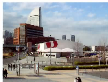
JICA横浜の前で建設が進むベイサイド会場
